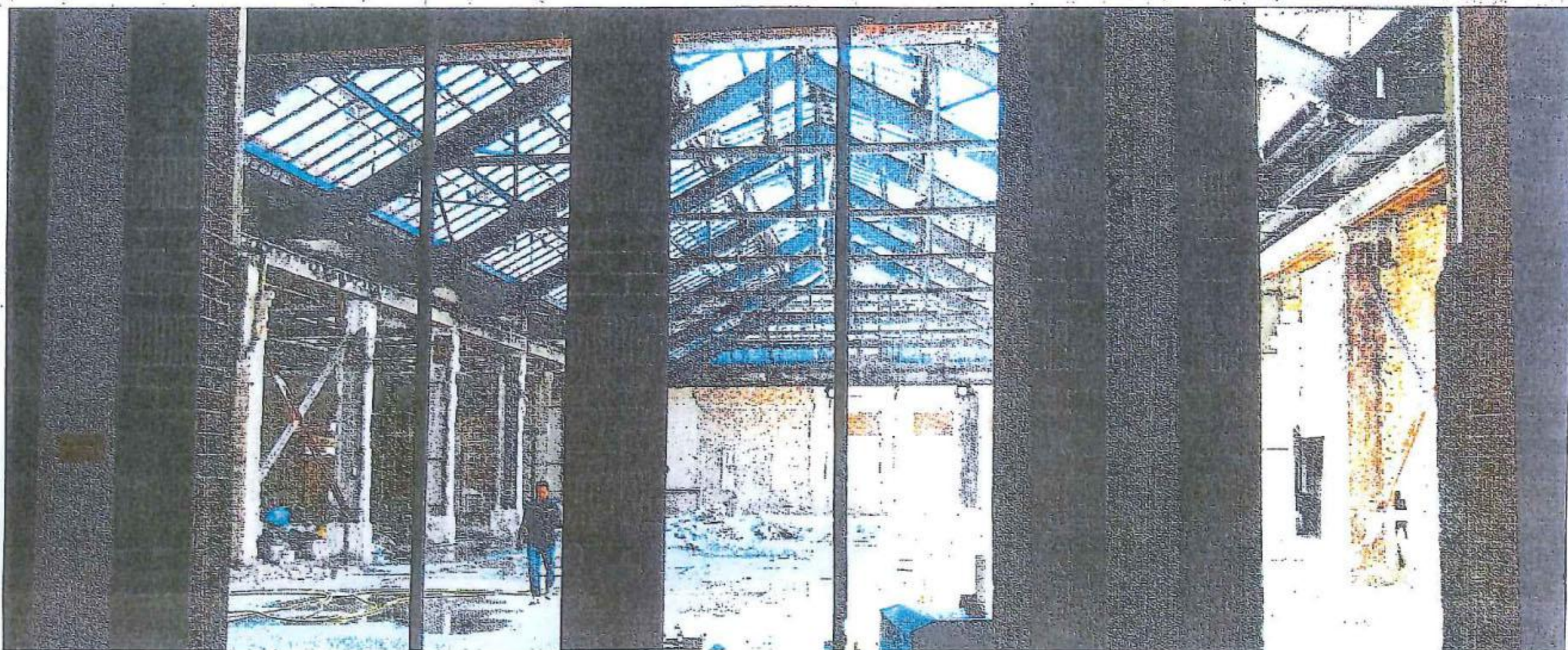
Blick auf die freigelegte Deckenkonstruktion der früheren Kassenhalle der AOK-Zentrale. Noch ist nur zu erahnen, wie es hier einmal aussehen soll. Bild: mv
