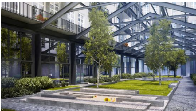
Ein Blick in den Innenhof des Hauses an der Rungestraße in Berlin-Mitte
